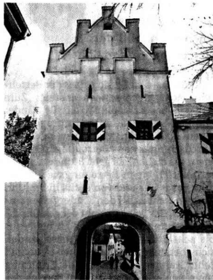
Die enge Zufahrt zum Domberg stellt die Logistiker beim Carmina Burana Openair vor Herausforderungen. FOTO: EFM
